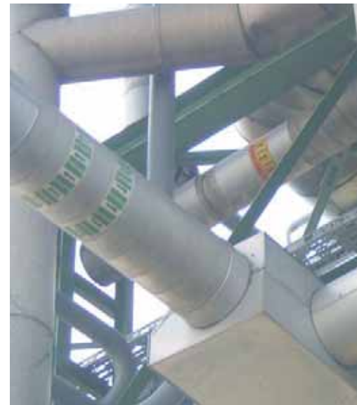
Stoffen wiens stroomrichting kan wisselen worden met twee markeringen naast elkaar gemarkeerd, zodat de ene pijl naar rechts en de andere pijl naar links wijst.
