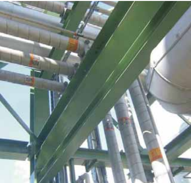
Bij onderbrekingen moet voor de onderbreking en aan de andere kant van de onderbreking gemarkeerd worden.
