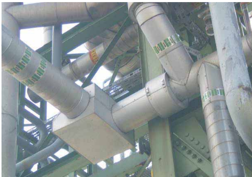
Elke leiding moet aan het begin en aan het einde gemarkeerd worden.
