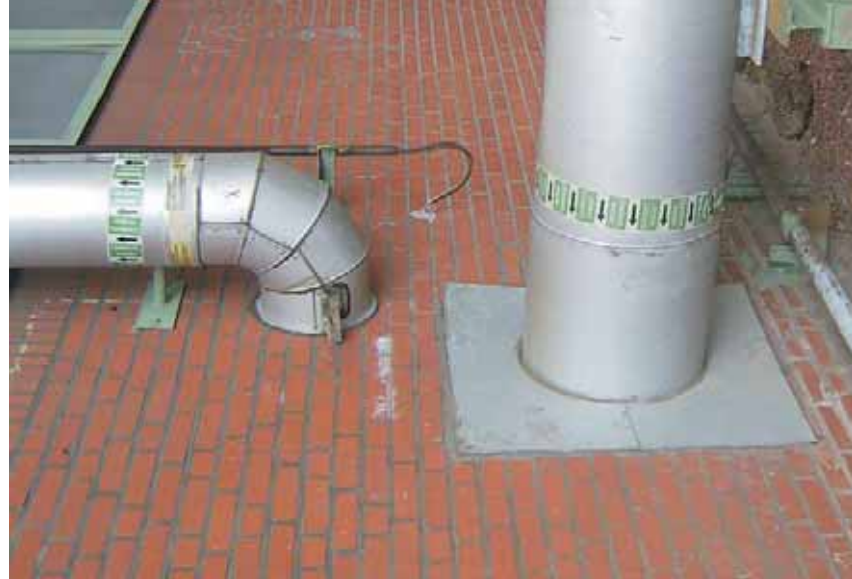
Bij muuronderbrekingen en vloerdoorvoeringen moet voor de onderbreking en aan de andere kant van de onderbreking gemarkeerd worden.
